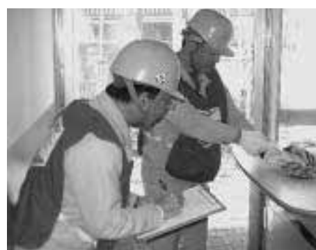
喫煙場所の点検巡視
